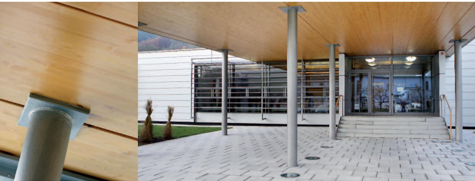
Es muss unbedingt sichergestellt werden, dass die Elemente während der Bauphase und im fertigen Gebäude trocken bleiben um Bauschäden, die durch Quellen von nass gewordenem Holz entstehen können, zu vermeiden. Das Quellen und Schwinden der Bauteile durch jahreszeitlich unterschiedliche klimatische Gegebenheiten ist entsprechend zu berücksichtigen.
